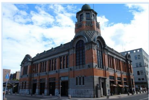
原國際航線候船室 舊大阪商船(1917)
